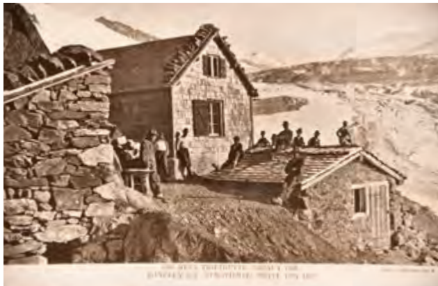
Die Trifthütte 1906. Die verschindelte Holzkonstruktion steht unmittelbar neben der kleinen 1867er-Hütte.
