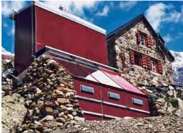
Die von Otto Lüthi entwickelte Kompostierungs-Toilette, die im Lawinenwinter 1999 zerstört wird.
