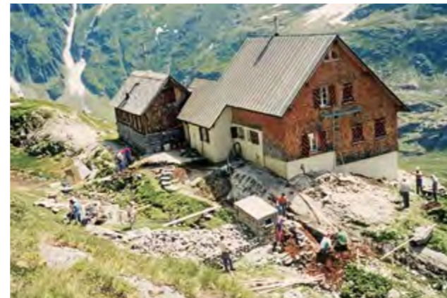
Die Gaulihütte. Hüttenwerker beim Terrassenbau.
