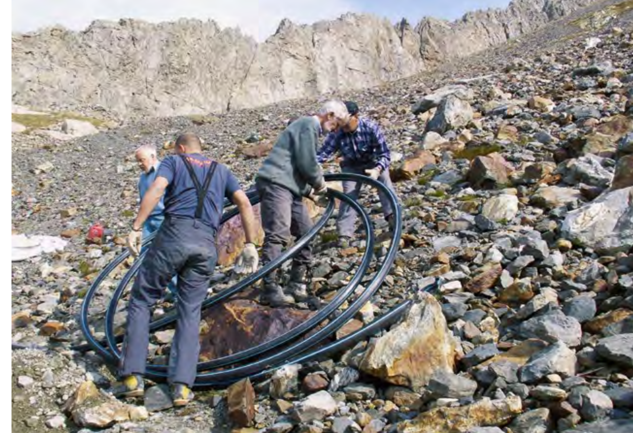
Die neue Wasserversorgung entsteht: Hüttenwerker in der Trift, 2008.
