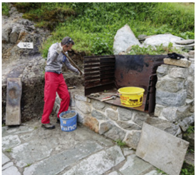
Jost Steiner bei Abbrucharbeiten des Grillplatzes bei der Windegghütte.
