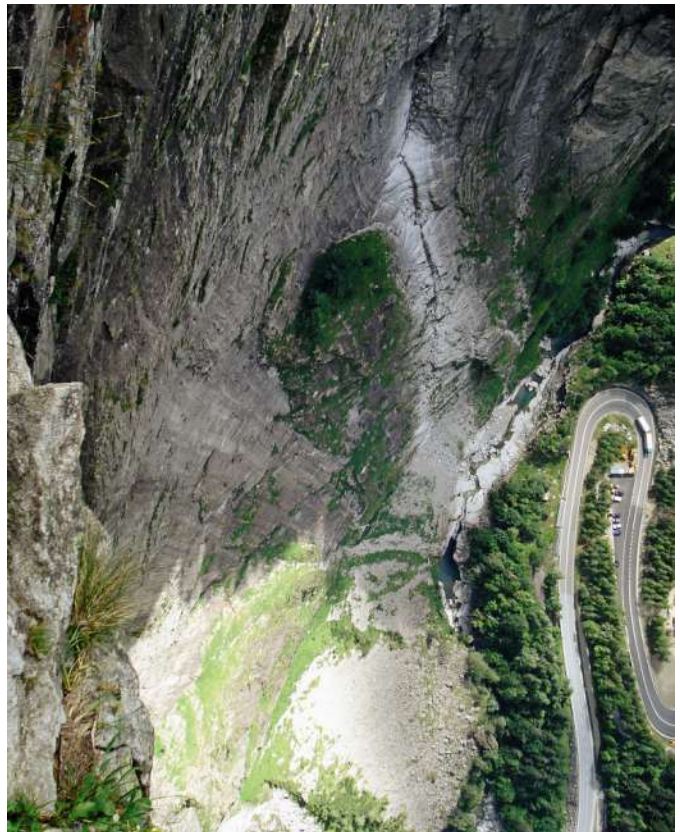
Tiefblick von der schattigen Volluz-Wand hinunter zur Simplonstrasse.
