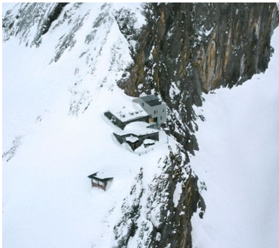
Der erste Winter nach dem Umbau. Inspektion aus der Luft.
