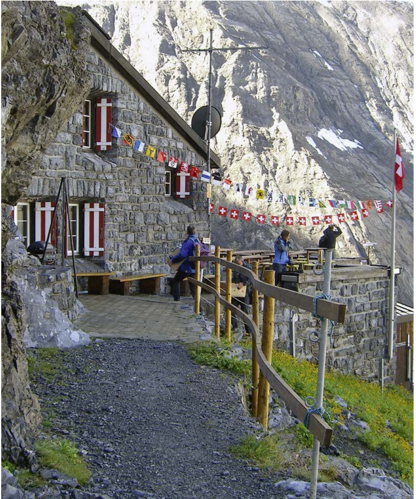
Die Gspaltenhornhütte zum letzten Mal im alten Kleid...
