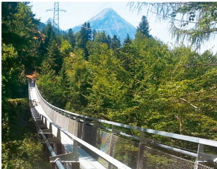
Spissibach-Hängebrücke bei Leissigen.
