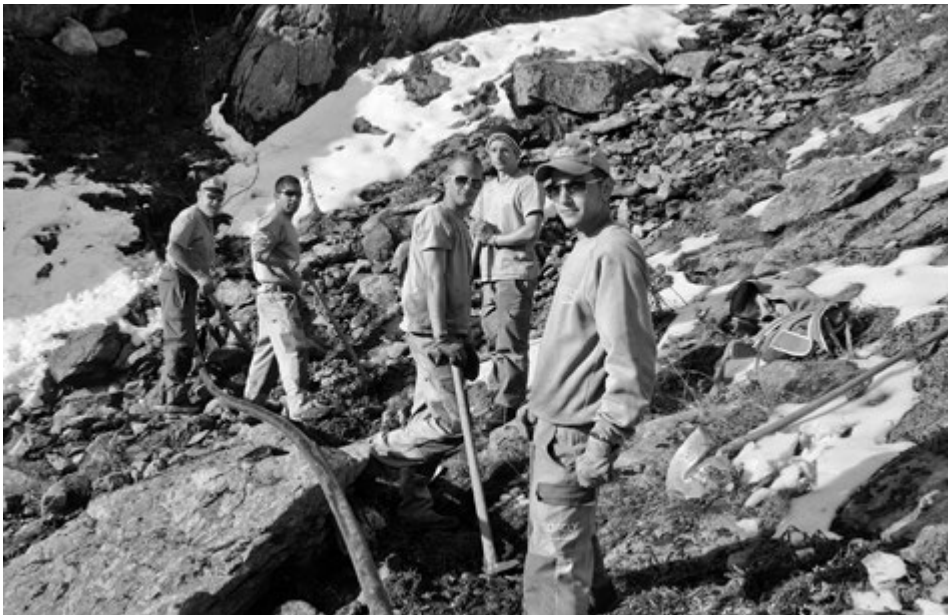
Die Lernenden von «Cofely» bei den Grabungen für die Rohrleitungen
