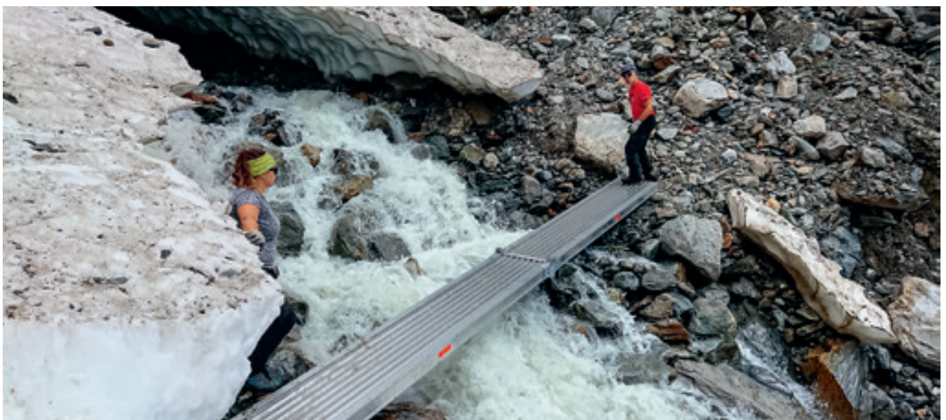
Die neuen Alustege auf dem Weg zur Trifthütte werden verankert.
