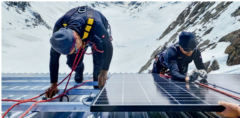
Arbeiten auf dem Westdach.
