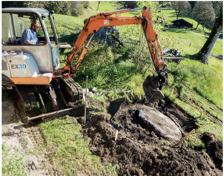
Nachbar Toni beim Baggern.
